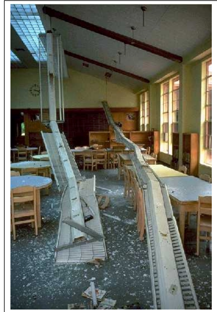
Desconexión de conectores o fijadores de lámparas
