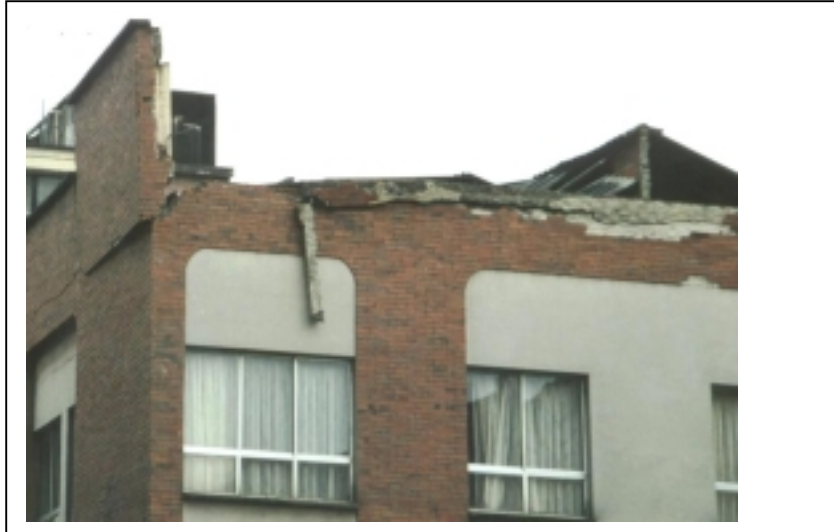
Daños en parapetos de ladrillo no reforzado
