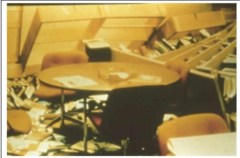
Daños en muebles y equipos
