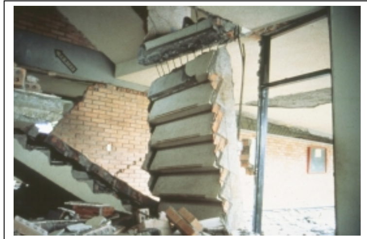
Daños en escaleras
