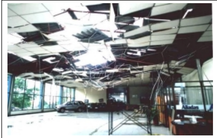
Daño en cielo raso
